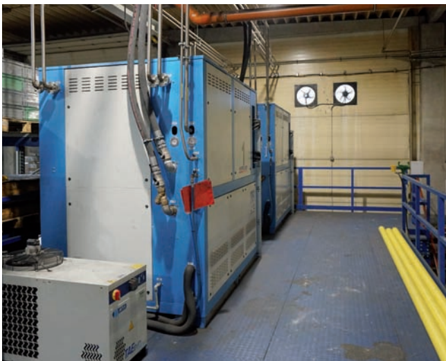
Dva generátory na výrobu zeleného vodíka
